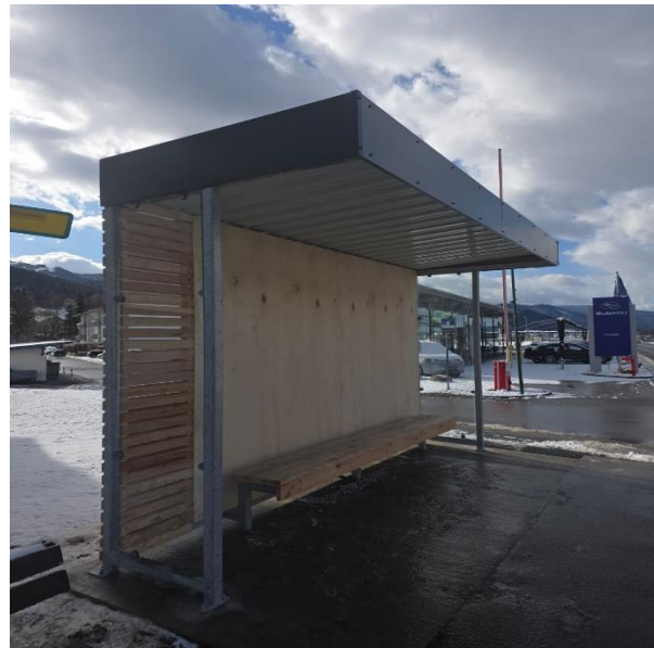
Wartehaus Mürzzuschlag, ST mit Blechverkleidung
